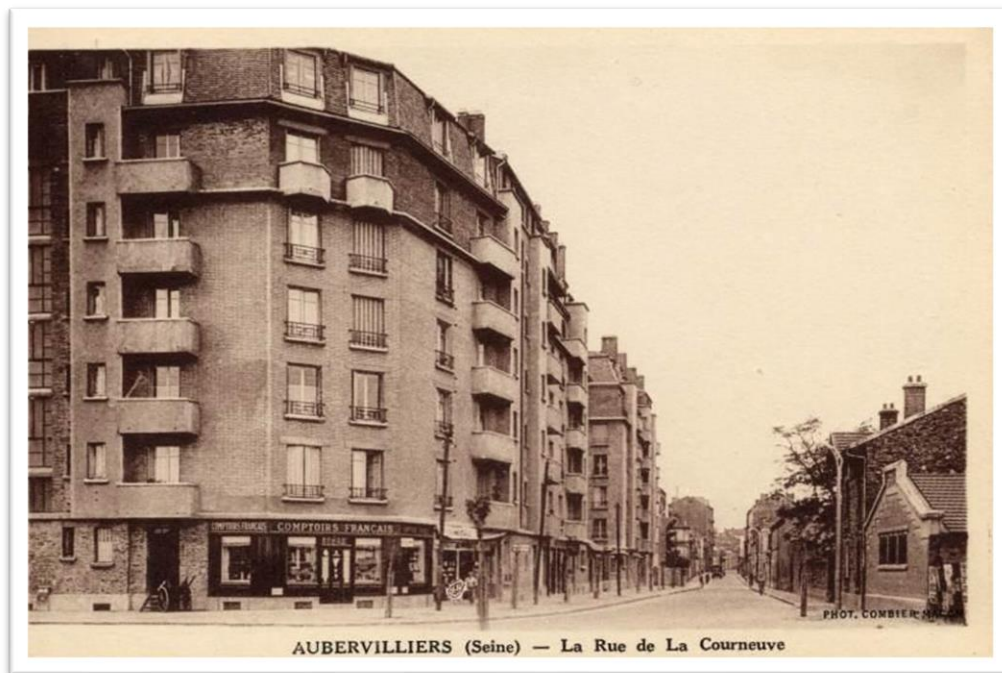
Un modèle d'«habitation bon marché» à Aubervilliers (Seine-Saint-Denis), première forme de logement social construite à la suite de la loi Siegfried de 1864. Crédits: Mémoire2Ville
